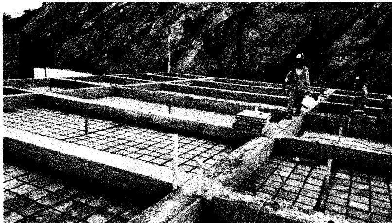
Foto 8: Asentado de ladrillo pastelero techo del área de Tareas Previas.
