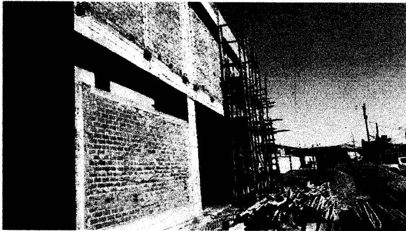
Foto 4: Tarrajeo en muros exteriores. Fachada lateral de la Zona de Frío.
